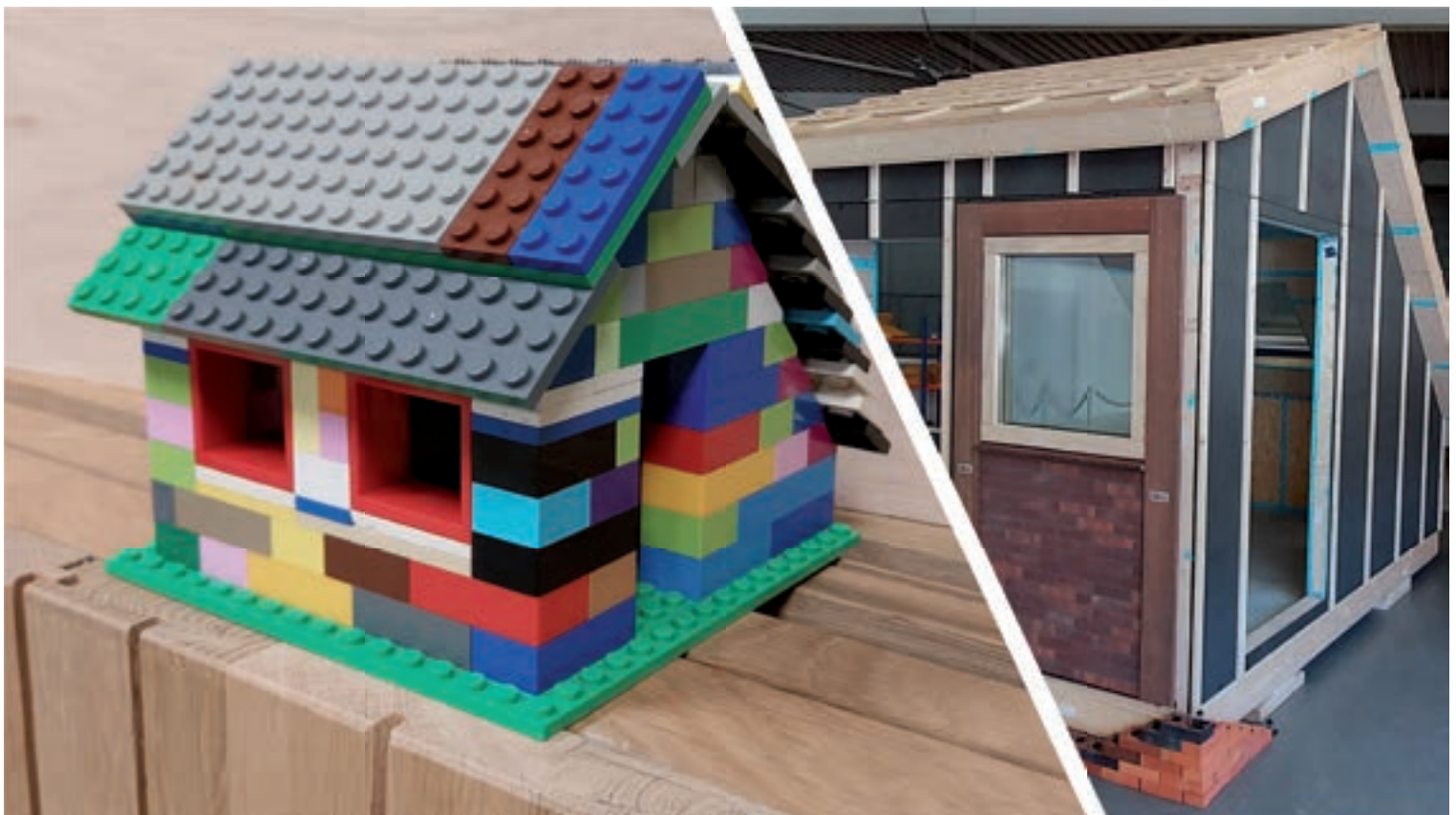
Prefab, circulair, biobased en remontabel test- en demohuis, InnovatieCentrum Ingenii te Harderwijk. Foto: Ingenii.
